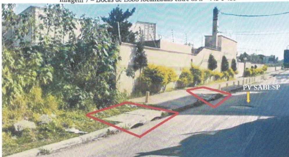
Imagem 7 – Bocas de Lobo localizadas entre os nº 445 e 455
