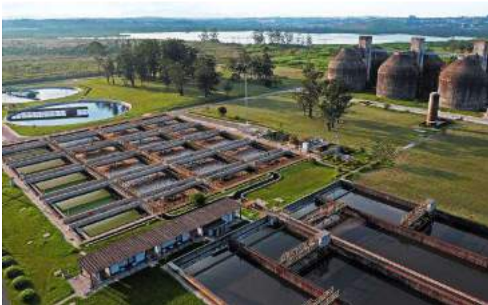
Figura 28 - Vista aérea da ETE Suzano
