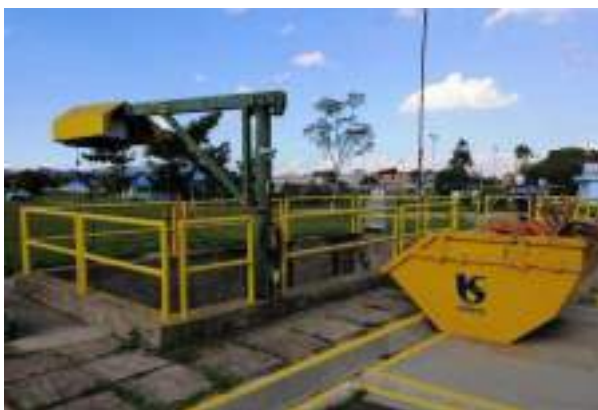
Figura 33 - Gradeamento fino
