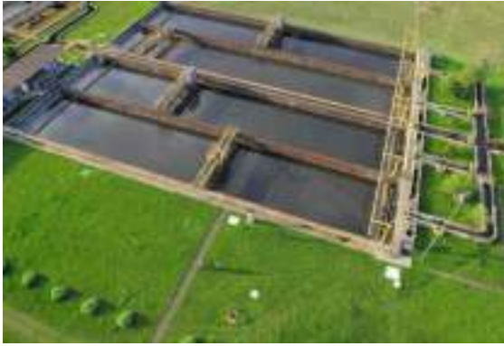
Figura 35 - Decantador primário
