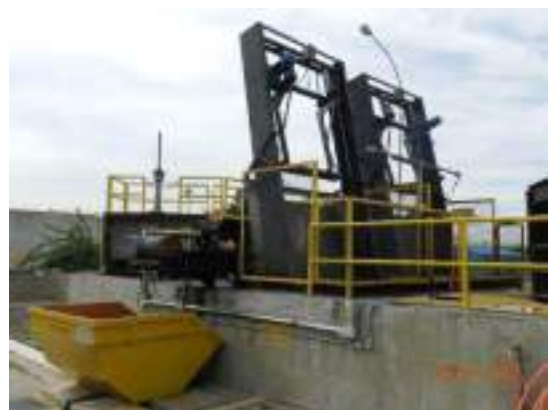
Figura 34 - Gradeamento grosso
