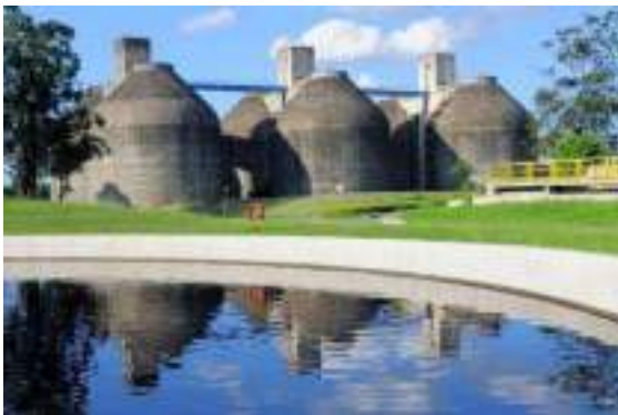
Figura 37 - Decantador Secundário e Digestores
