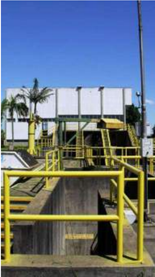
Figura 31 - Elevatória de Esgoto Final
