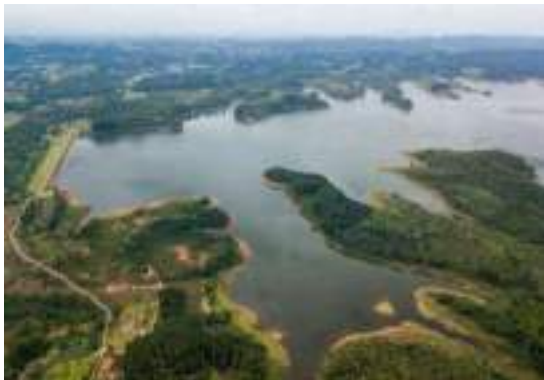
Figura 16 - Represa Ponte Nova
