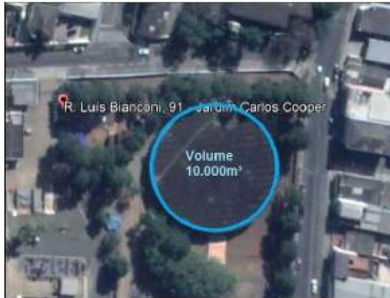
Figura 21 - Vista aérea do Reservatório de Distribuição de Suzano
