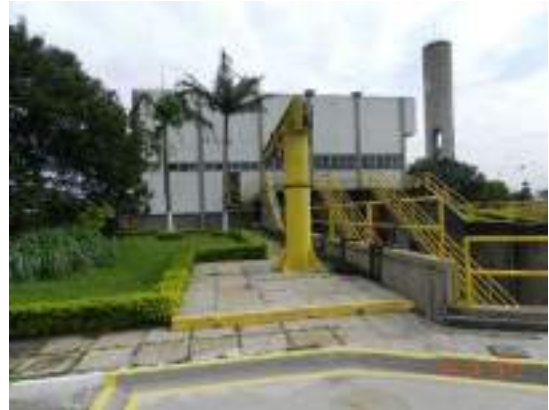
Figura 32 - Elevatória de Esgoto Final
