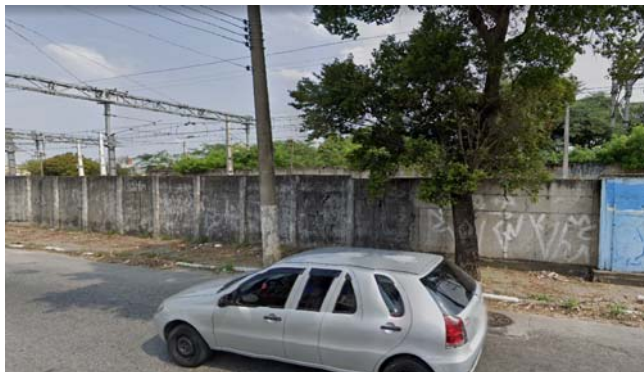
Fonte: Google Linha de Transmissão de energia
