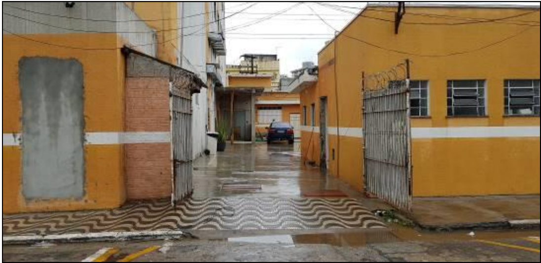
Figura 22: HOSPITAL MEDCARE – Acesso principal de ambulâncias – através da Rua Sebastião Luiz
