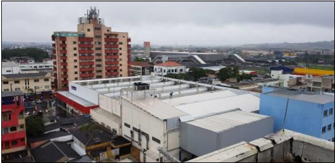
Figura 13: HOSPITAL MEDCARE – Vista da edificação hospitalar para estação de Trem Suzano
