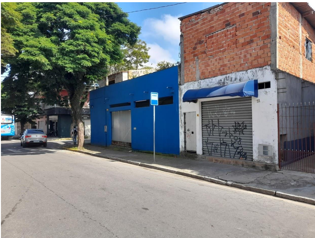
Figura 27. Parada de ônibus na Rua Amélia Guerra, próximo ao nº 746 Fonte: Emerson Nakiri, 2021
