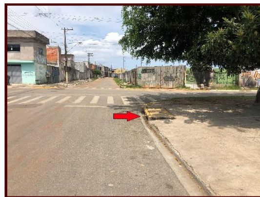
Figura 4.12 – Boca de Lobo.
