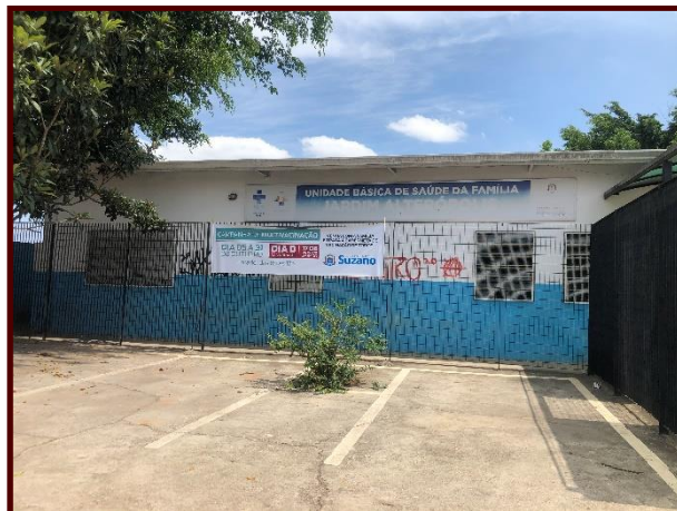
Figura 4.4 – UBS – Rua Manoel H. dos Santos.
