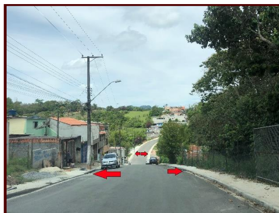
Figura 4.13 – Boca de Lobo na via de acesso do empreendimento.
