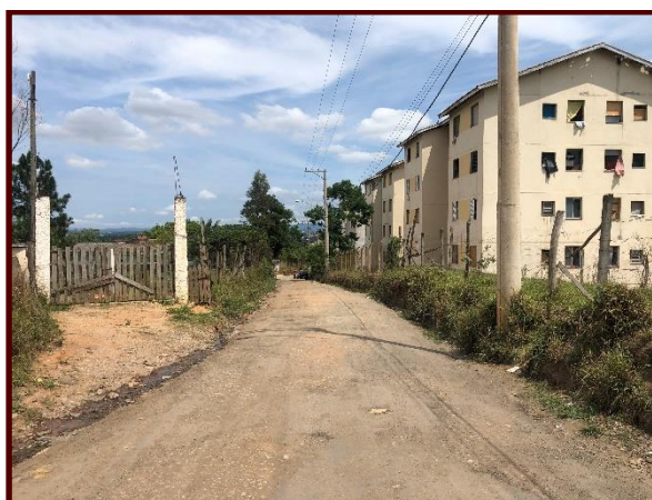
Figura 6.2 – Rede Elétrica – Acesso ao empreendimento.
