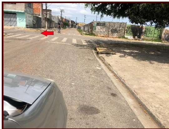
Figura 4.11 – Poço de Visita.
