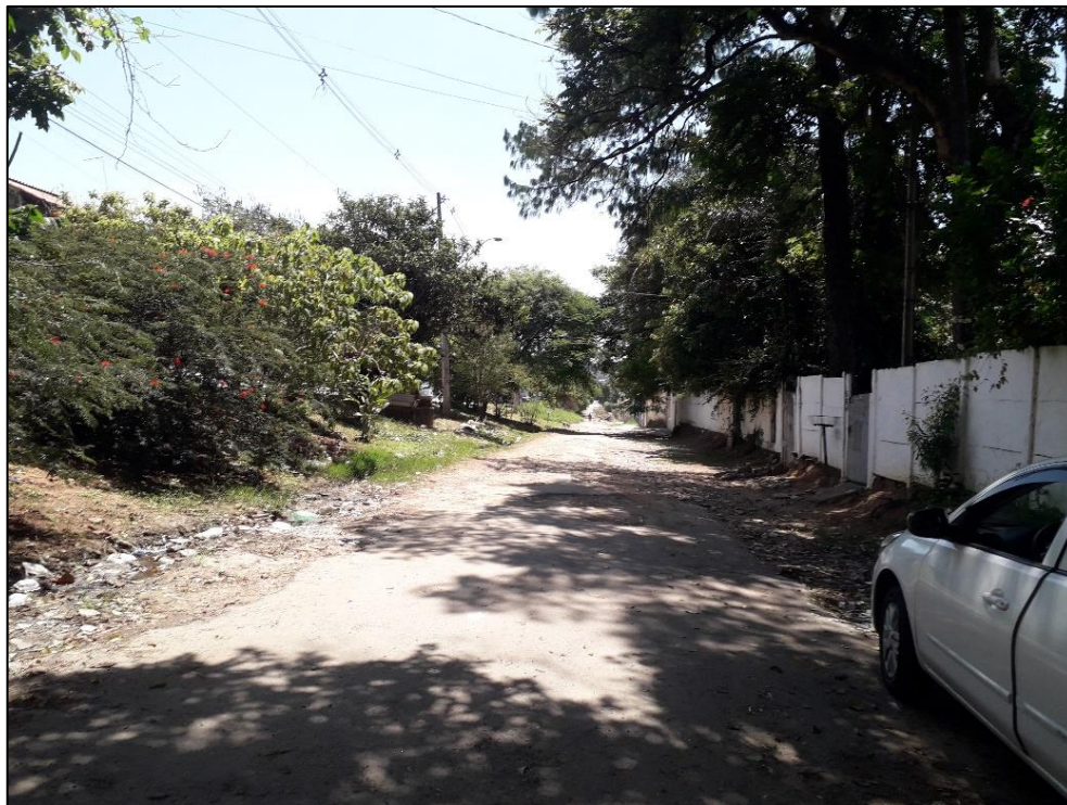
Foto 05: Estado atual de conservação da Av. Jaguari, à esquerda da entrada do empreendimento atual.
