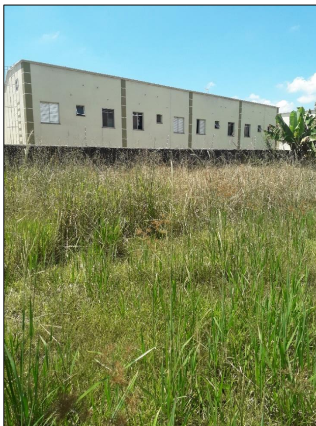
Foto 06: Vista do Condomínio aos fundos do empreendimento.
