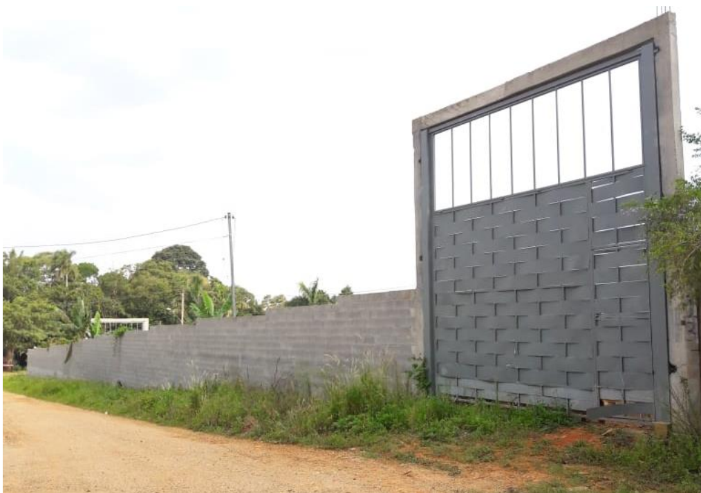
Figura 4 – Vista frontal da área analisada: R. Dalcy Dionísia Brito, entrada e saída de carga e descarga
