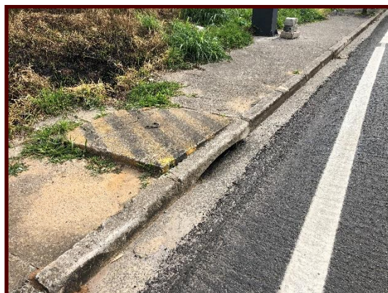
Figura 4.13 – Boca de Lobo no acesso à área de empreendimento.
