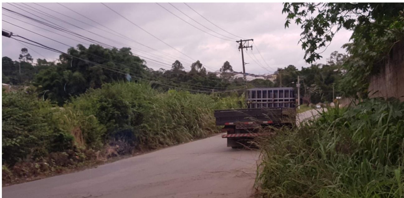
Imagem 07: Estrada Fazenda Viaduto
