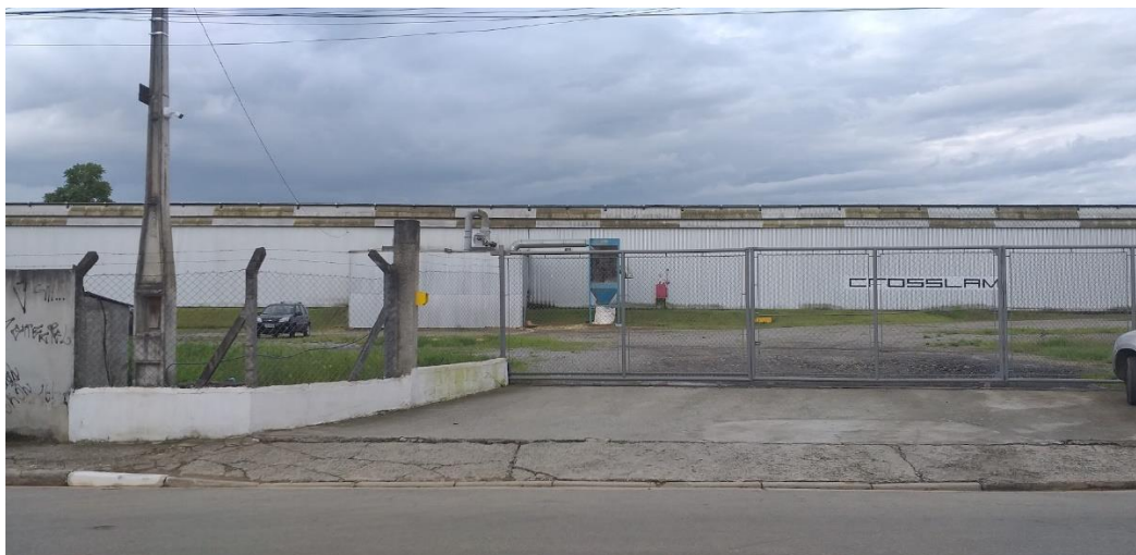
Imagem 18 – Recuo no portão principal de acesso para que os veículos não obstruam a via durante a abertura do portão
