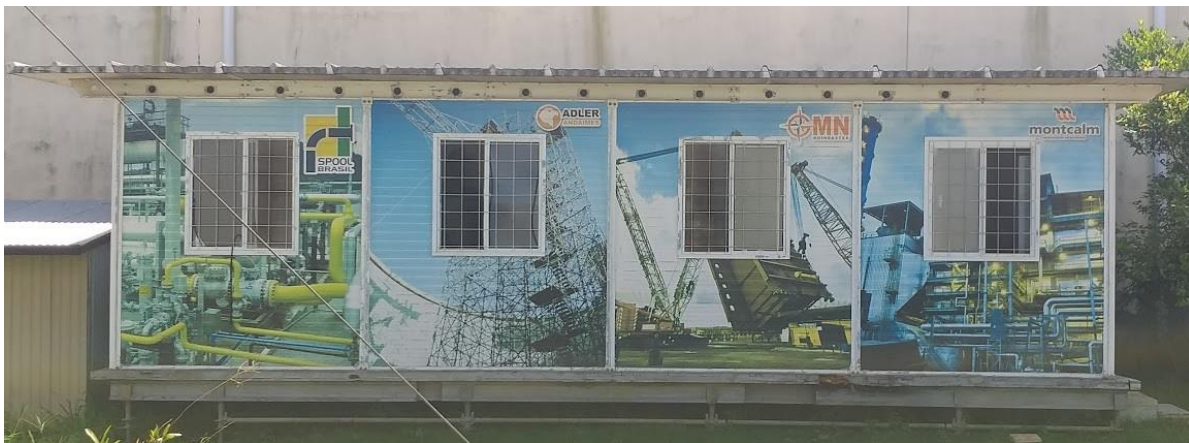
Imagem 3 - Instalação Provisória III (Refeitório)
