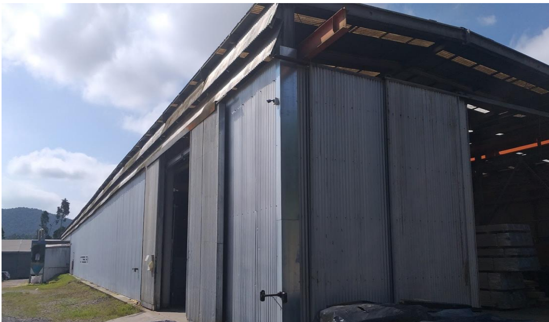
Imagem 1 - Instalação Provisória I (Produção)
