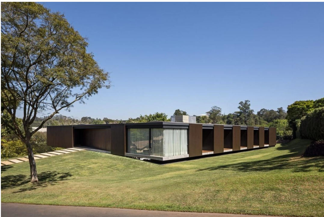
Imagem 11 – Construção em painéis de Madeira Laminada Cruzada
