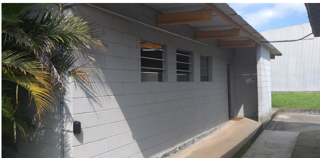
Imagem 7 - Instalação Definitiva II (Sanitários e Vestiários)
