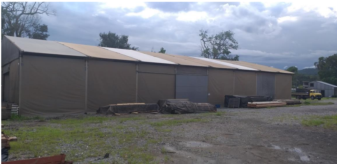
Imagem 5 - Instalação Provisória IV (Depósito de Metais) utilizados nas montagens das estruturas
