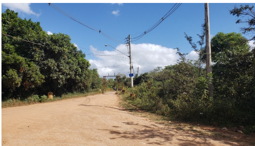
Figura 8: Passagem sobre o Rio Tietê.
