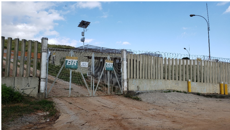
Figura 22: Estação da Transpetro na Estrada Joaquim P. de Carvalho.
