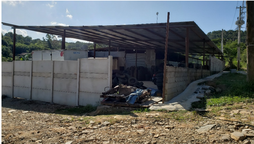
Figura 16: Vista da indústria de remoldagem de pneus.
