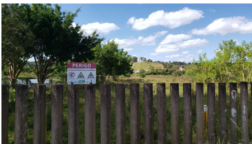
Figura 9: Dutos da Transpetro, na Estrada José Conceição.
