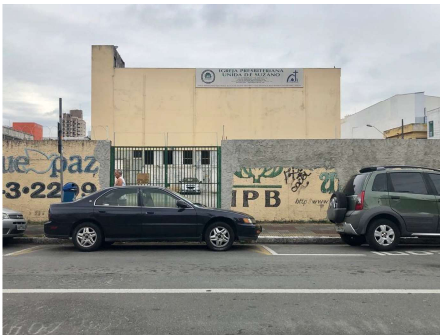
Fotografia 3 - Lateral do empreendimento (Rua Benjamin Constant).
