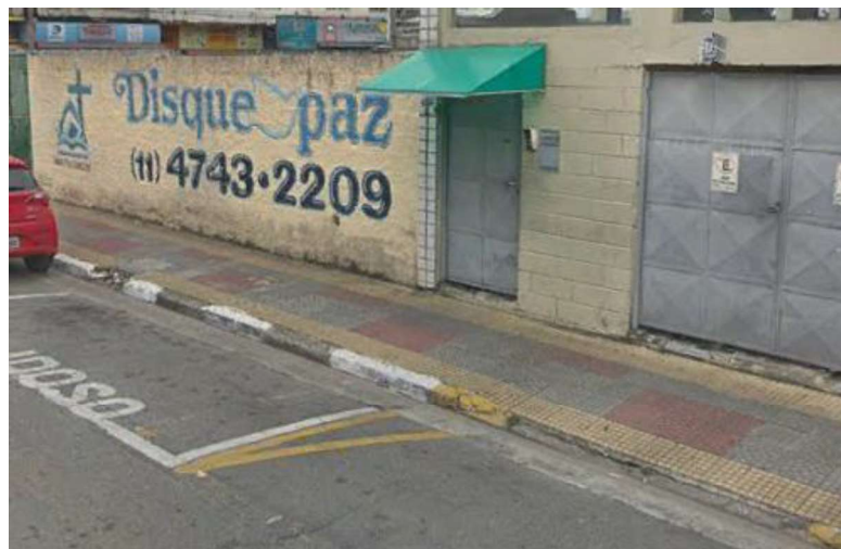
Fotografia 35 - Calçada do empreendimento.
