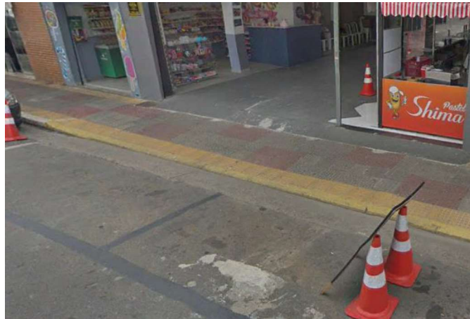
Fotografia 36 - Calçada dos arredores.
