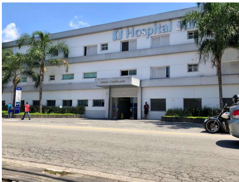
Fotografia 1 - Fachada do empreendimento (Av. Armando Salles de Oliveira).
