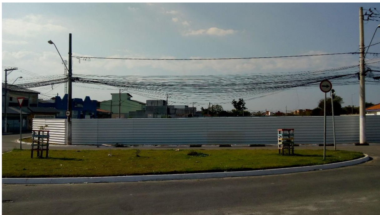
Imagem 10: Terreno para a construção da creche
