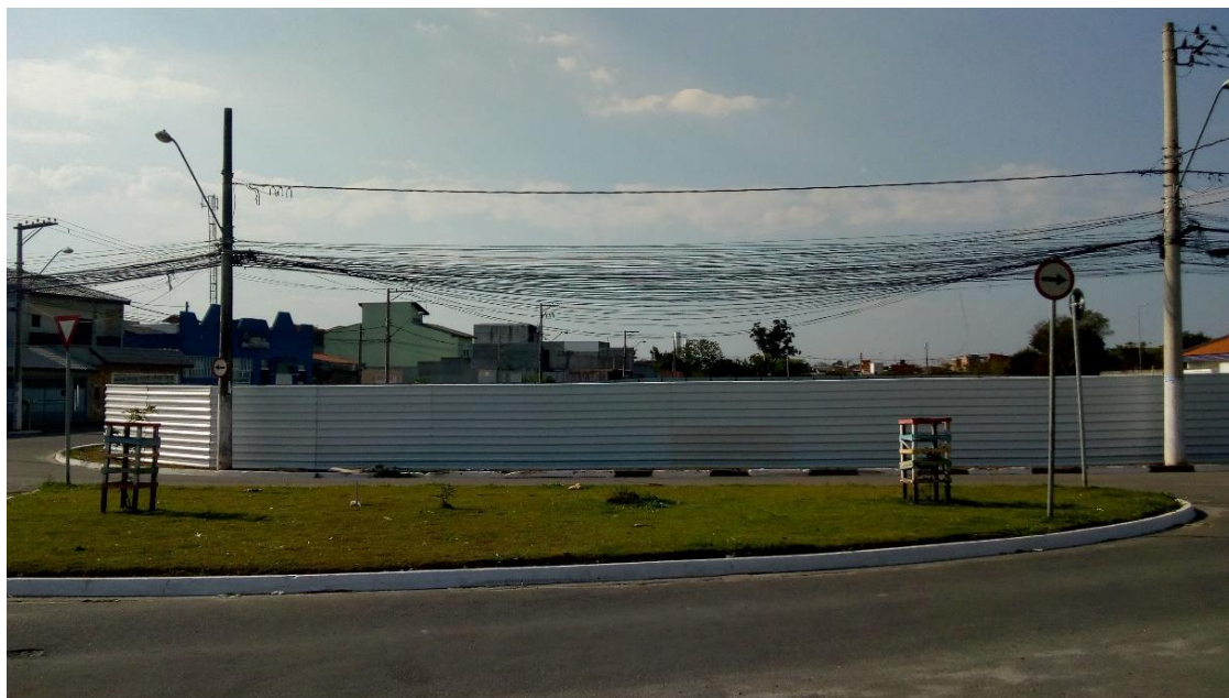
Imagem 17: Terreno para a construção da creche
