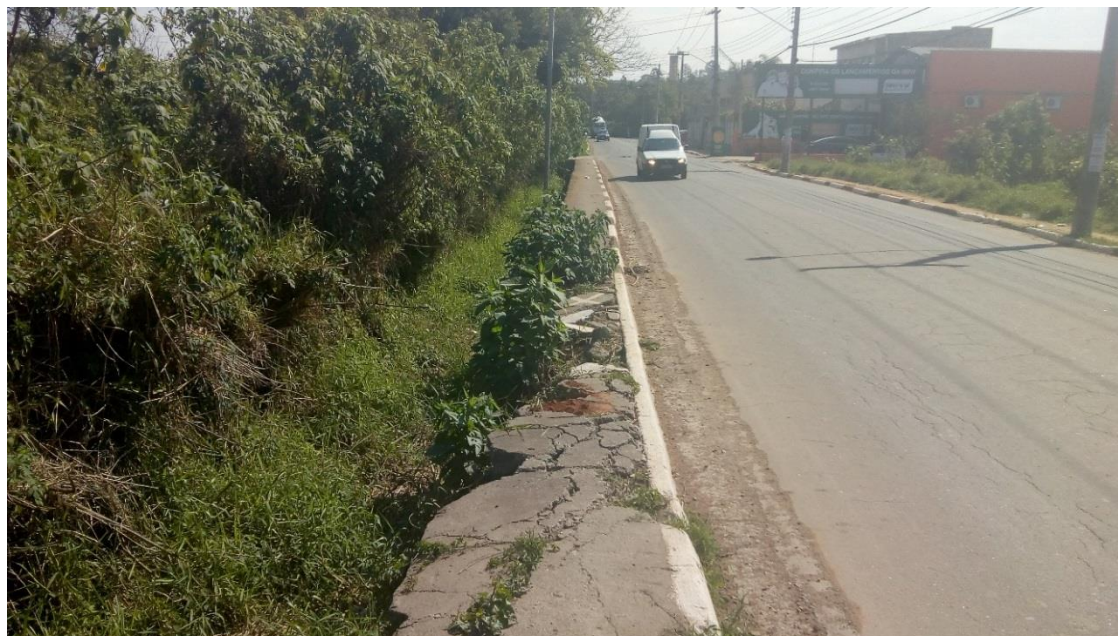
Imagem 10: Acesso a estrada Okabe a esquerda, vindo da Chácara Faggion
