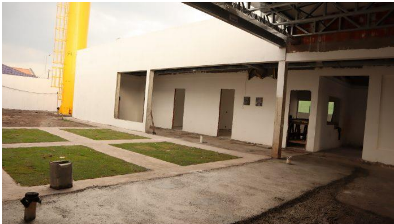
Imagem 07: Escola Jd. Quaresmeira – Em Construção
