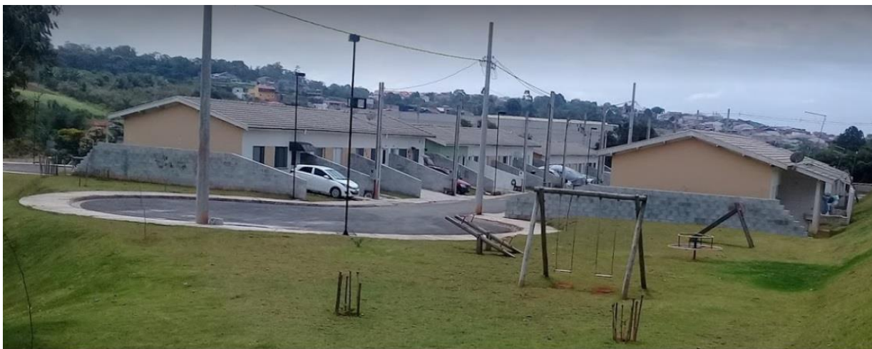
Figura 11 - Condomínio Carmim Sabadin – Estrada Fazenda Viaduto
