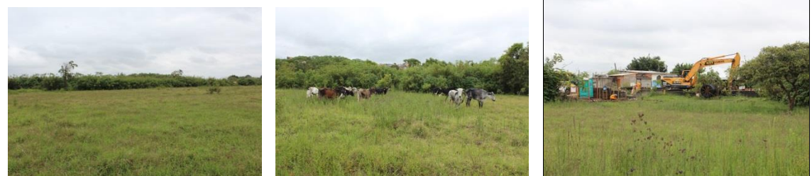
Fotos – Campo limpo, presença de animais de grande porte e TransPetro executando obras.
