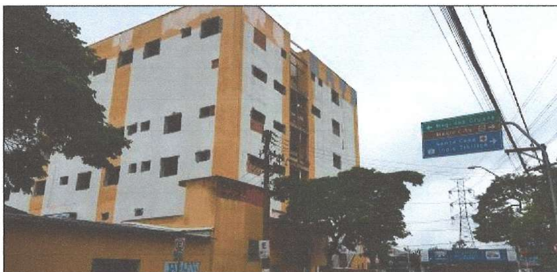
Figura 18: HOSPITAL MEDCARE – Vista da Rua Felício de Camargo – acesso à Av. Antônio Marques Figueira – Mogi das Cruzes e também bairro Índio Tibiricá
