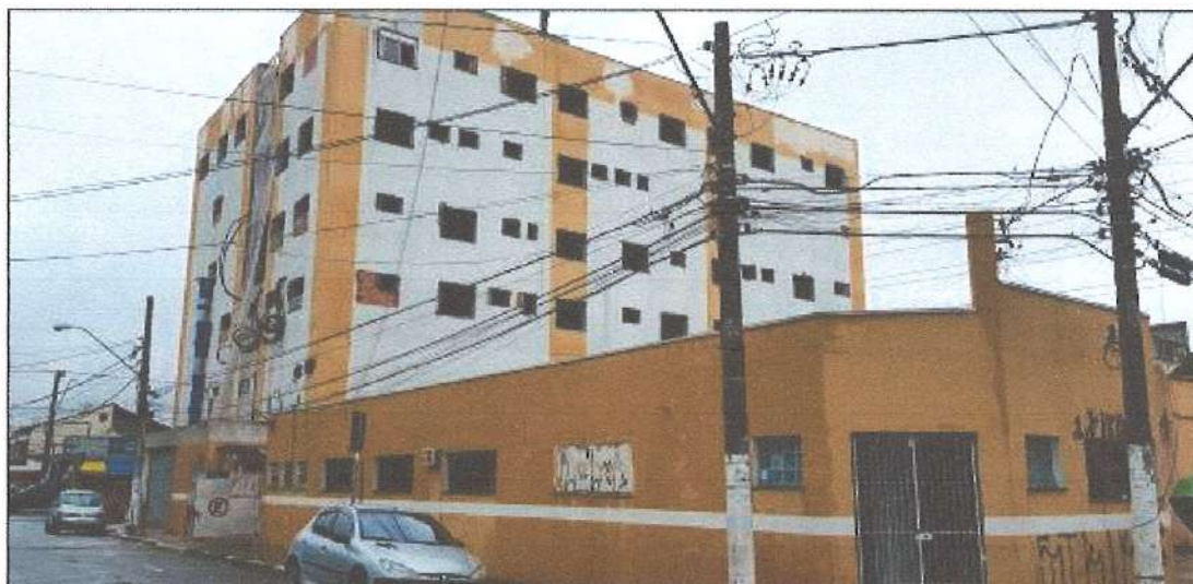
Figura 21: HOSPITAL MEDCARE – Vista da Rua Sebastião Luiz – Situação atual da Edificação
