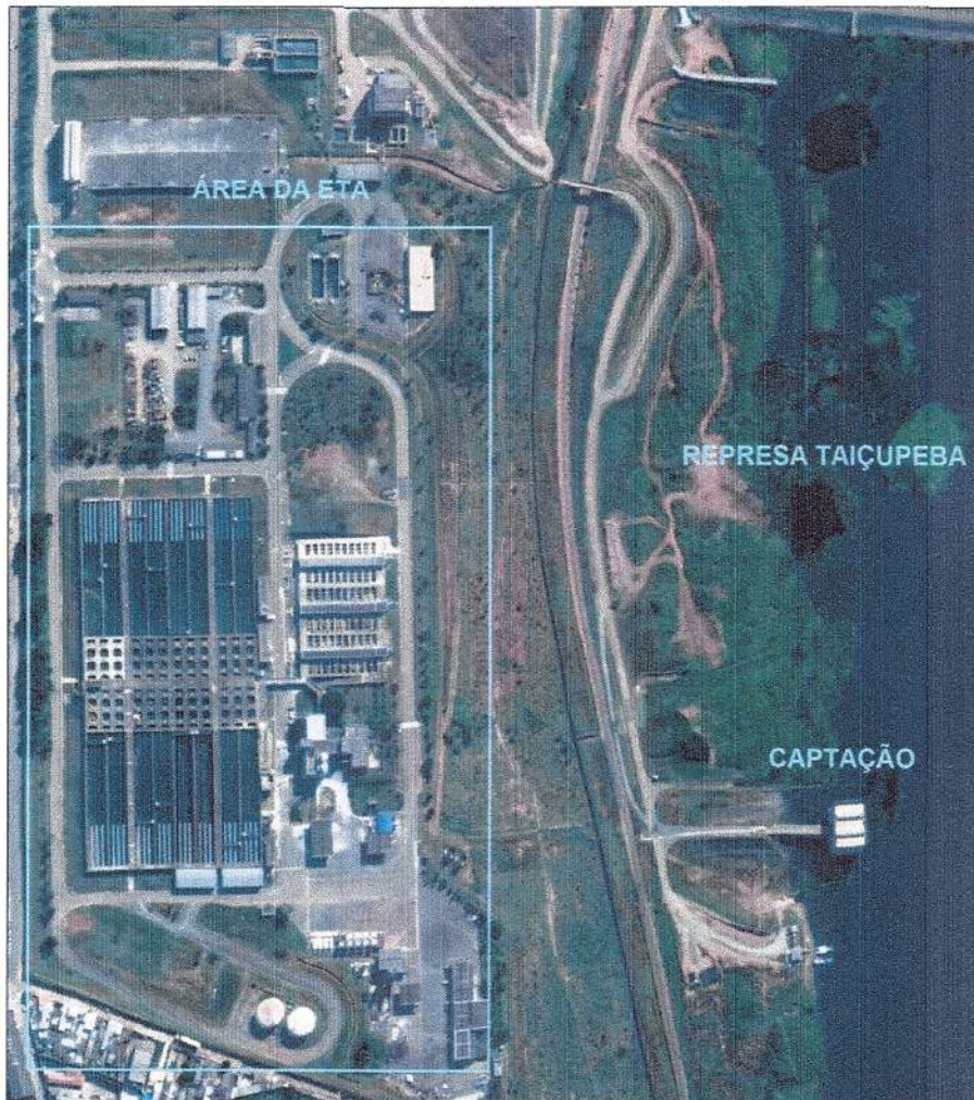
Figura 21 - Vista aérea da ETA Taiçupeba
