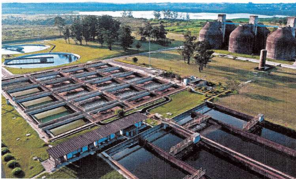
Figura 32 - Vista aérea da ETE Suzano
