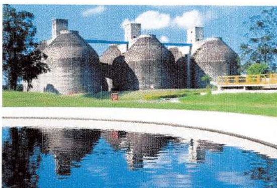
Figura 41 - Decantador Secundário e Digestores
