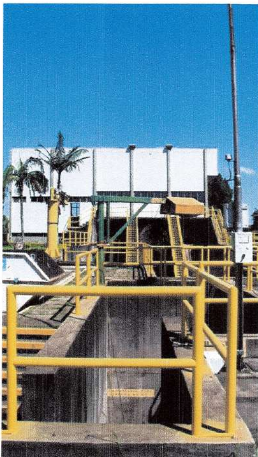
Figura 35 - Elevatória de Esgoto Final Fonte: Sabesp
