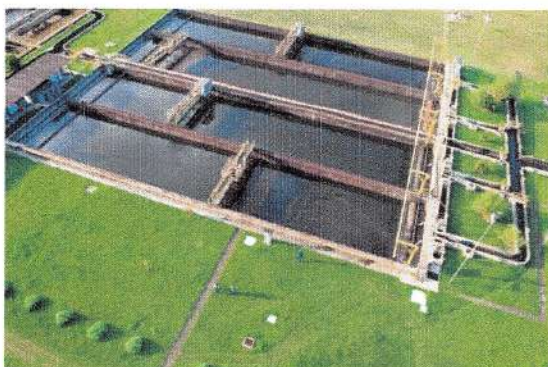
Figura 39 - Decantador primário
