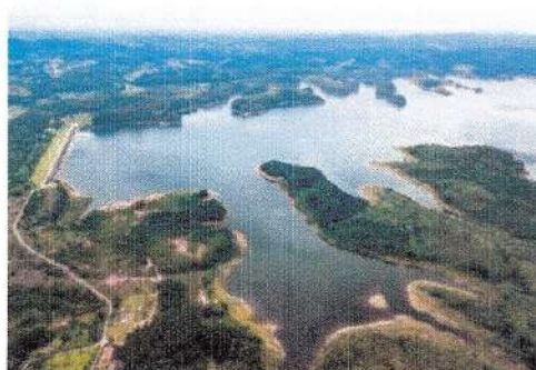
Figura 19 - Represa Ponte Nova Fonte: Sabesp
