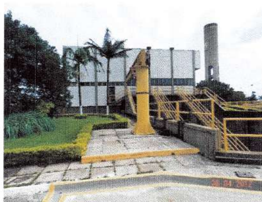
Figura 36 - Elevatória de Esgoto Final Fonte: Sabesp
