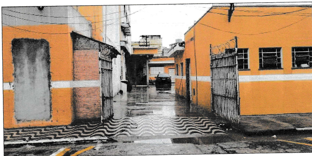
Figura 21: HOSPITAL MEDCARE – Acesso principal de ambulâncias – através da Rua Sebastião Luiz
