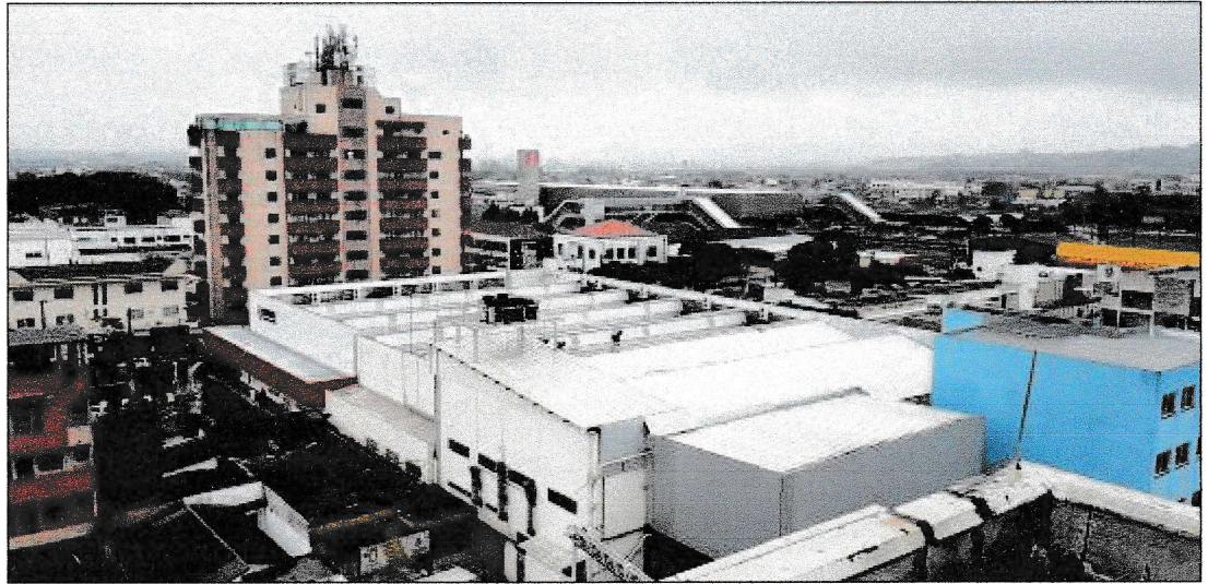
Figura 12: HOSPITAL MEDCARE – Vista da edificação hospitalar para estação de Trem Suzano
