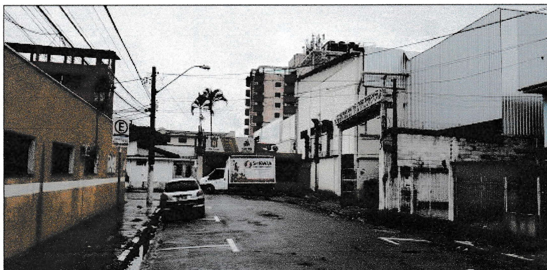
Figura 15: HOSPITAL MEDCARE – Vista da Rua Sebastião Luiz – sentido único
