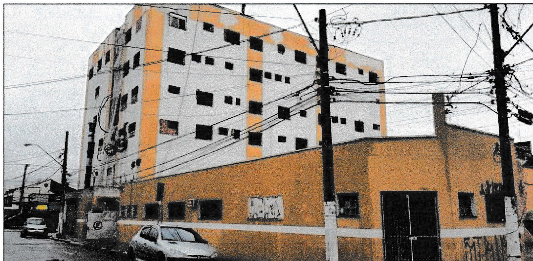
Figura 20: HOSPITAL MEDCARE – Vista da Rua Sebastião Luiz – Situação atual da Edificação
