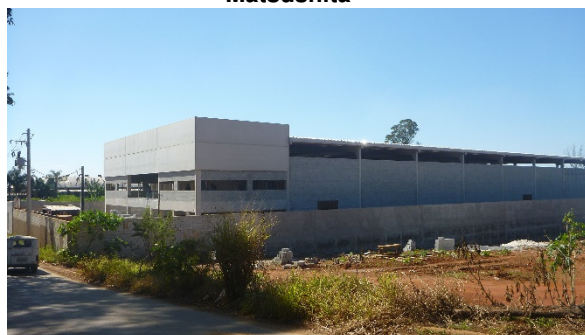
Foto 5.8 – Construção de galpão industrial na rua Mitsuharu Matsushita
