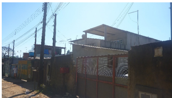
Foto 5.12 – Residências localizadas na Estrada Geraldo Miranda, via sem pavimentação
