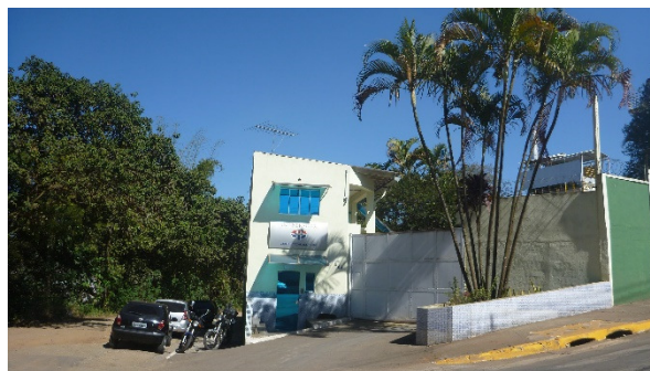
Foto 5.30 - Estação de Incineração de resíduos da empresa Pioneira Saneamento e Limpeza Urbana, Estada Antonio Jorge, esquina com a Rua Antonio da Surreição
