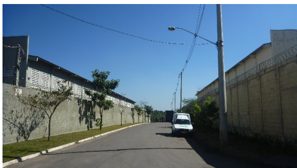
Foto 5.31 - Galpões na Rua Antonio Mazini Rodrigues
