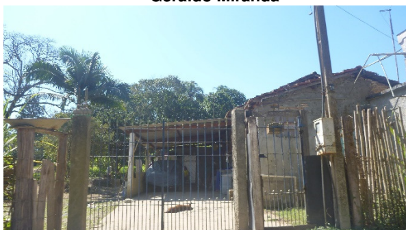
Foto 5.13 – Residências localizadas na Estrada Geraldo Miranda, via sem pavimentação
