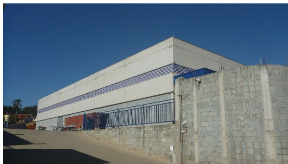
Foto 5.18 – Galpão na Estada Fazenda Viaduto
