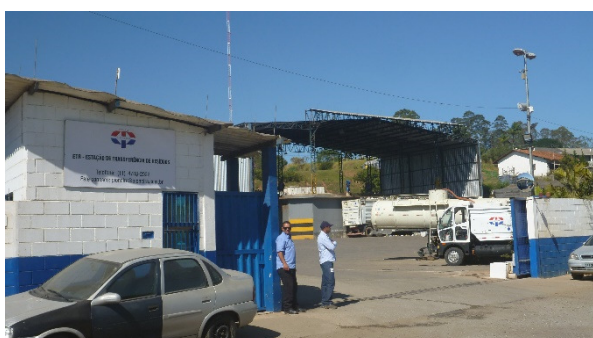
Foto 5.15 – Estação de Transferência de Resíduos da empresa Pioneira Saneamento e Limpeza Urbana, entrada na Estrada Fazenda Viaduto, via com pavimentação
