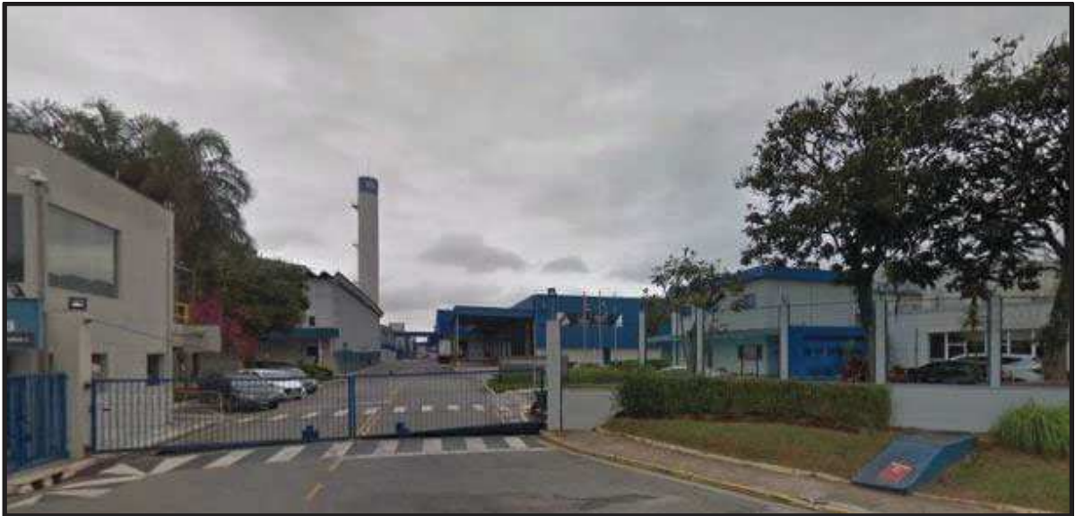
Figura 6 – Portaria 1 - Rua Brasfanta Fonte: Google Earth Pro
