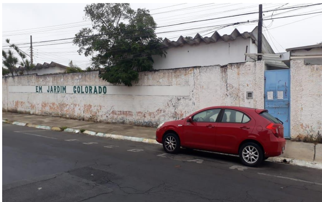
Figura 6.2 - Escola Municipal Jardim Colorado
