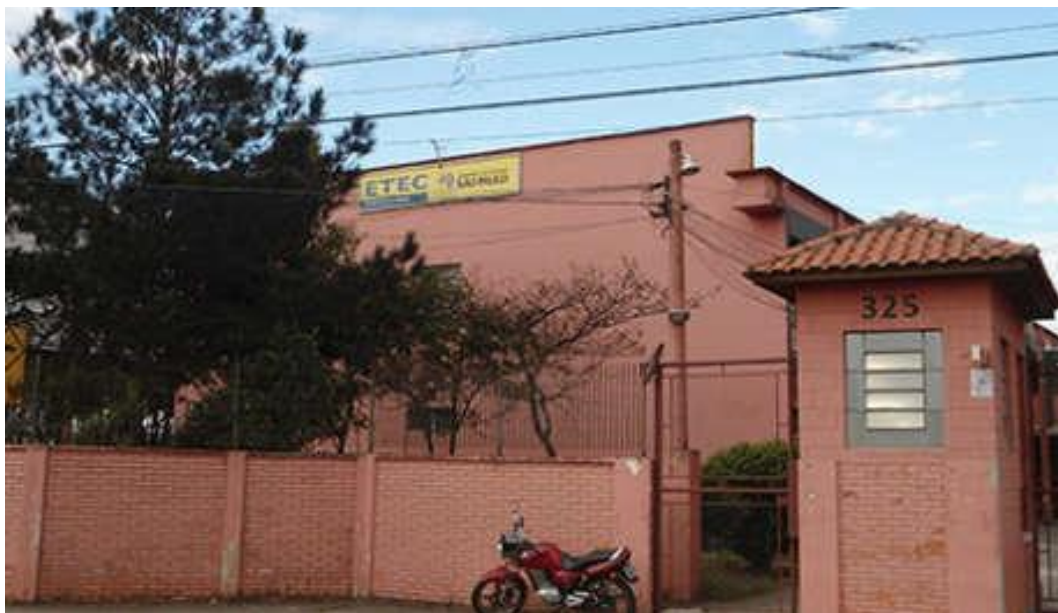
Figura 6.5 – ETEC de Suzano
