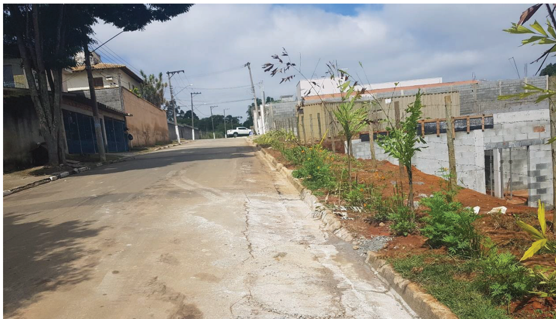
Imagem 04: Residências antigas em frente a Obra de um empreendimento residencial
