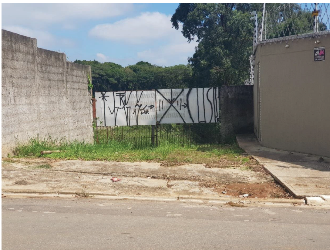
Imagem 03: Entrada do futuro empreendimento
