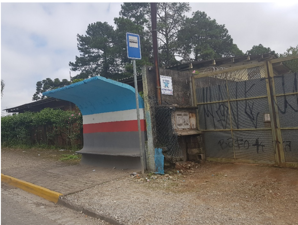
Imagem 20: Ponto de Ônibus (Abrigo)
