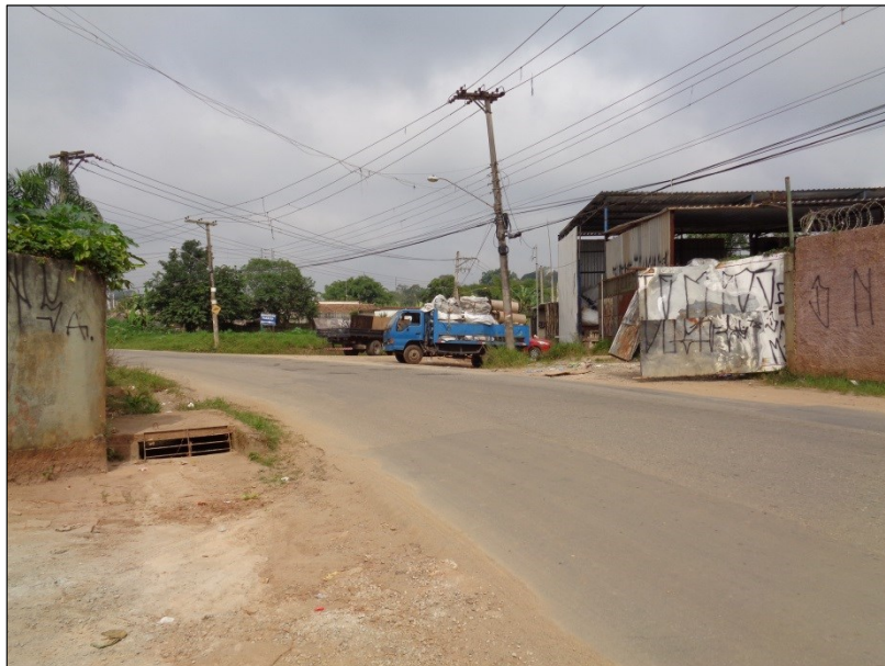
Figura 47: Drenagem Estr. do Viaduto. Fonte: Master Ambiental, 2019.
