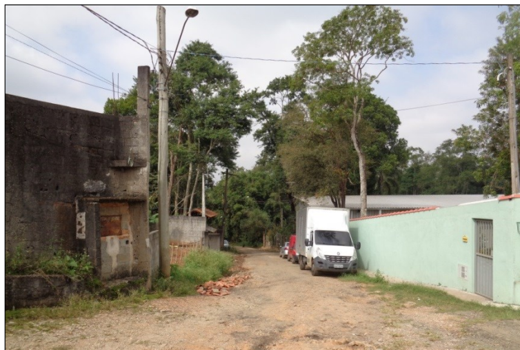
Figura 27 – Ausência de passeio na Rua Servidão Dois, por onde se dará o acesso do empreendimento. Fonte: Master Ambiental, 2019.
