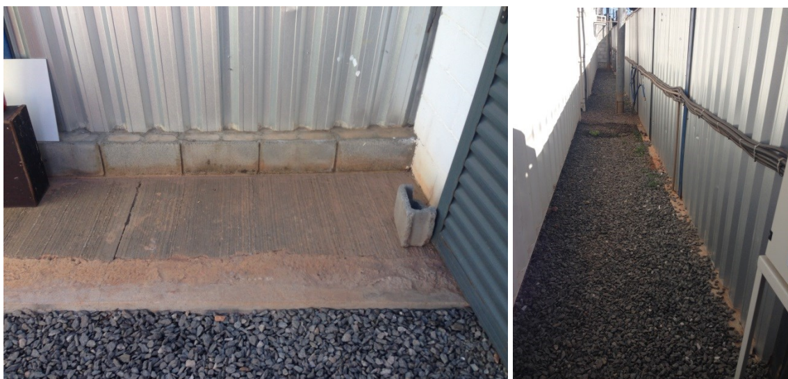
Figura 49: Proteção do canteiro de obras para erosão e sedimentação Fonte: Master Ambiental, 2019
