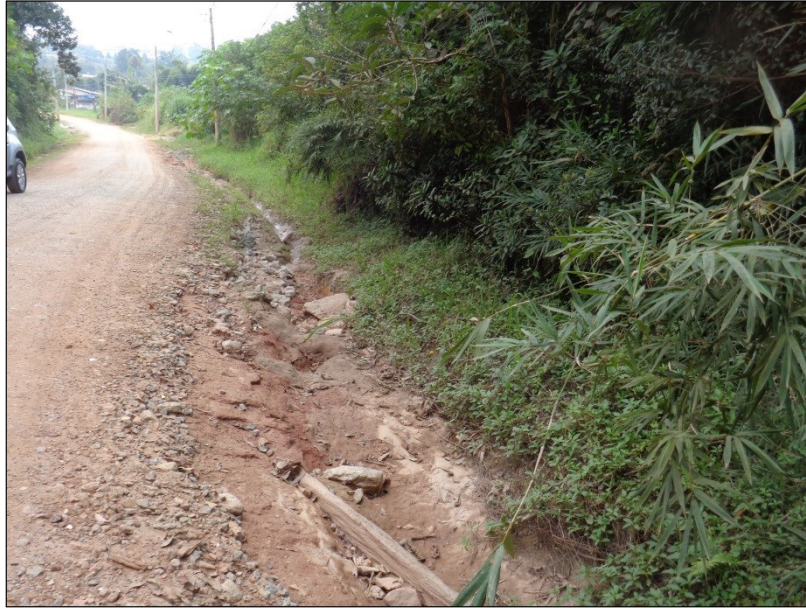
Figura 46: Drenagem R. Servidão Dois. Fonte: Master Ambiental, 2019.
