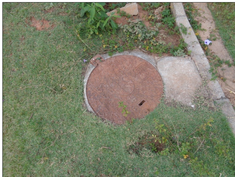
Figura 50: Acesso ao sistema de esgoto existentes no interior do terreno. Fonte: Master Ambiental (2019).
