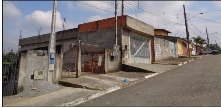
Figura 24 – Situação do passeio próximo ao empreendimento, com diversas interferências. Fonte: Master Ambiental, 2019.
