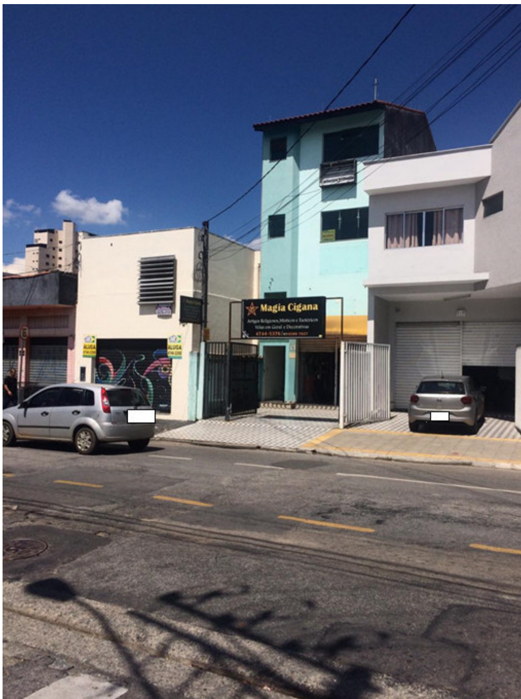
Foto 5.2.1. Prédio a direita da edificação, loja de artigos religiosos.
