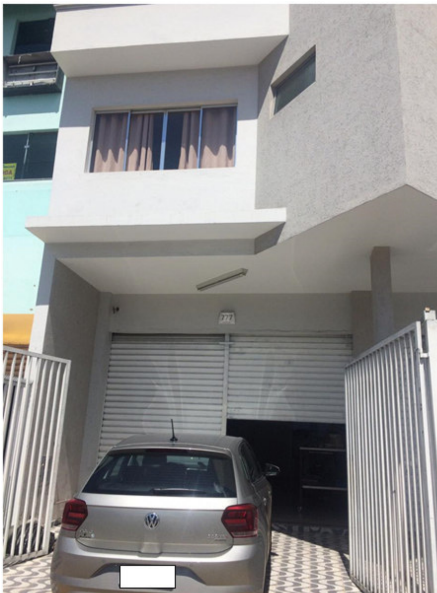
Foto 4.4.2. Foto da fachada.
