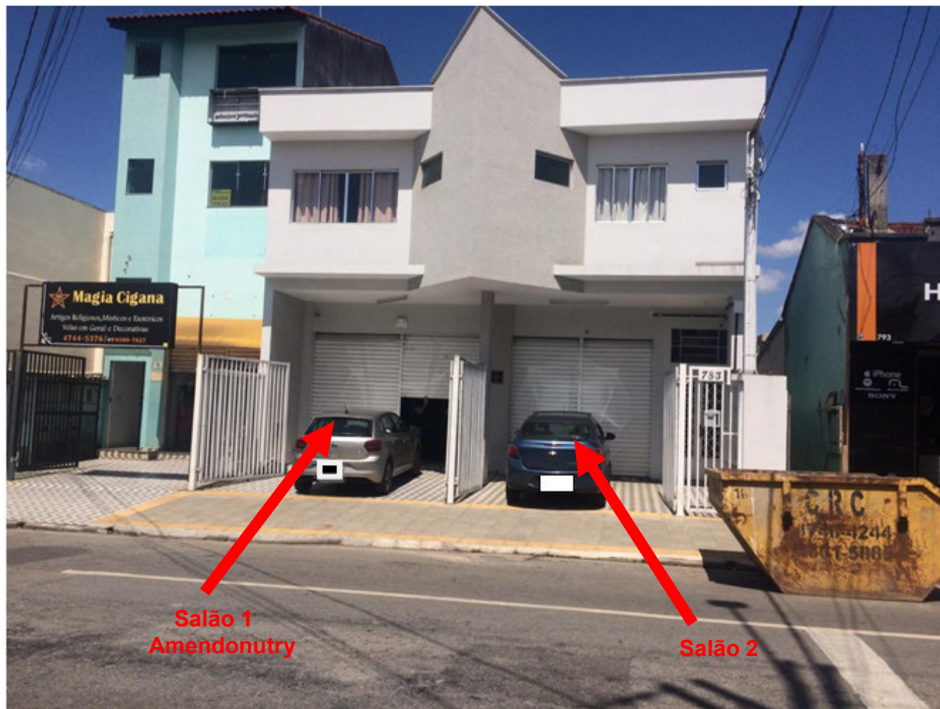
Foto 4.1.2. No pavimento térreo existem dois salões comerciais, independentes, denominados salão 1 e 2, ambos com 62,00 m 2 de área construída.
