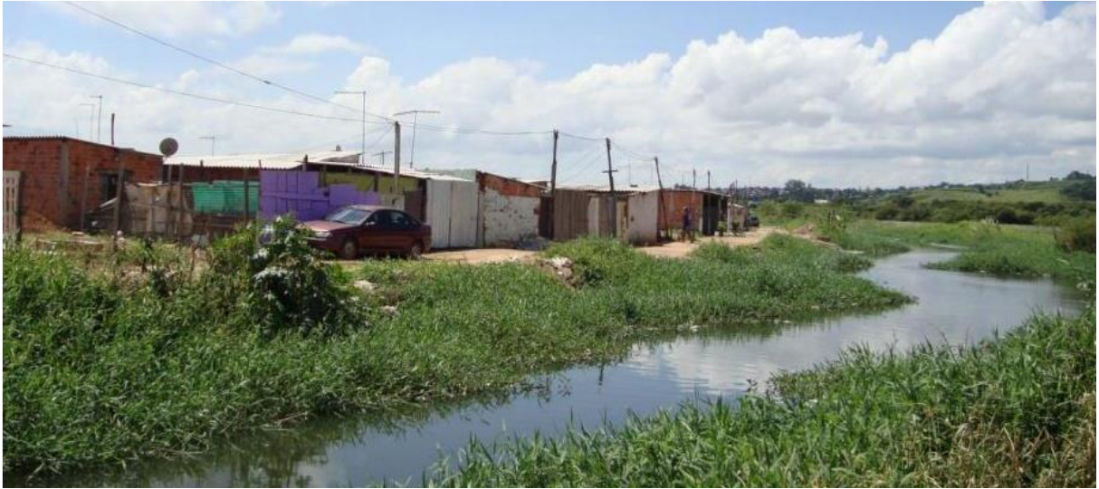
Figura 45: Vista parcial da ocupação irregular recente sobre a várzea do rio Tietê. Extremidade do canal implantados na margem esquerda do rio Tietê - na Rua Albert Finke, Parque Maria Helena. Porção da AID. Visada para norte-nordeste.
