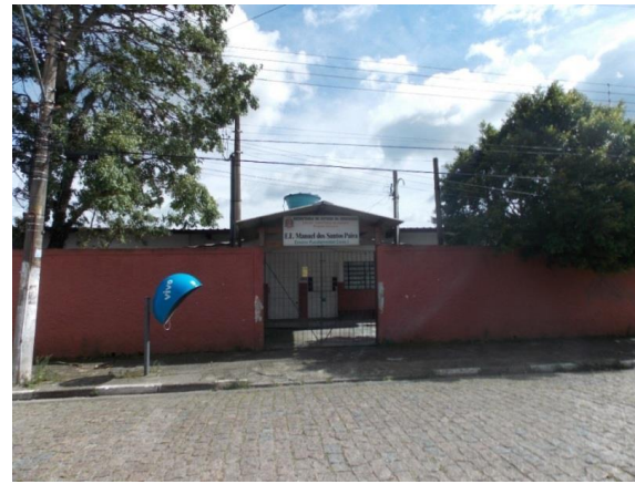
Figura 58: E.E. Manuel dos Santos Paiva, no bairro Vila Maluf, nas proximidades do empreendimento.
