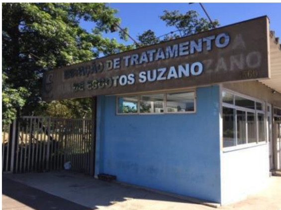
Figura 12: Faixada da ETE SABESP, na margem esquerda da Av. Major Pinheiro Fróes sentido SE. (limite da AII).
