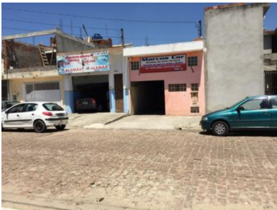
Figura 46: Vista da fachada de duas oficinas mecânicas na Av. Albert Finke.
