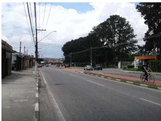
Figura 82: Av. Vereador João Batista Fitipaldi na altura da fachada da Denver Ltda. (a direita na imagem) e ciclovia em seu canteiro central, com vista para NE.
