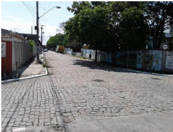
Figura 95: Rua Teresa Clementina Tomasine de Freitas no cruzamento com Av. Albert Finke, com pavimentação de paralelepípedo.
