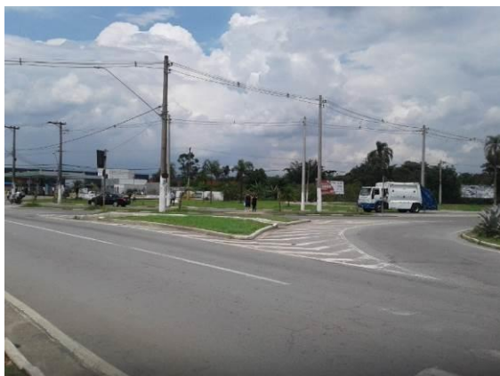
Figura 84: Acesso para o viaduto Governador Mario Covas na Av. Vereador João Batista Fitipaldi.
