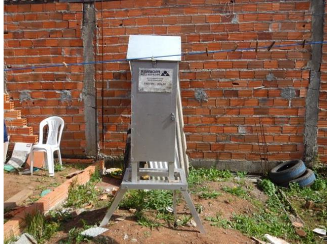
Figura 28: Ponto de monitoramento HV1, localizado na residência da Sra. Bárbara a sudeste do empreendimento.
