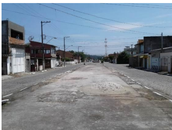
Figura 92: Av. Albert Finke no cruzamento com a Rua Teresa Clementina Tomasine de Freitas com canalização do canteiro central fechada.
