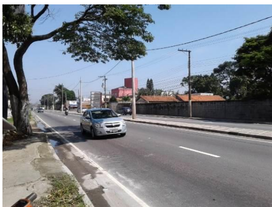
Figura 74: Av. Major Pinheiro Fróes no limite da propriedade da SABESP, cujo muro pode ser visto a direita na imagem. (Próxima a saída da Alternativa 4 - Figura 89).
