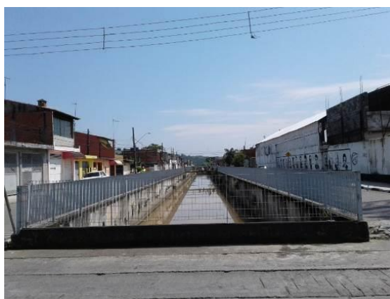
Figura 93: Av. Albert Finke no cruzamento com a Rua Corifeu de Azevedo Marques e canalização do canteiro central aberta.
