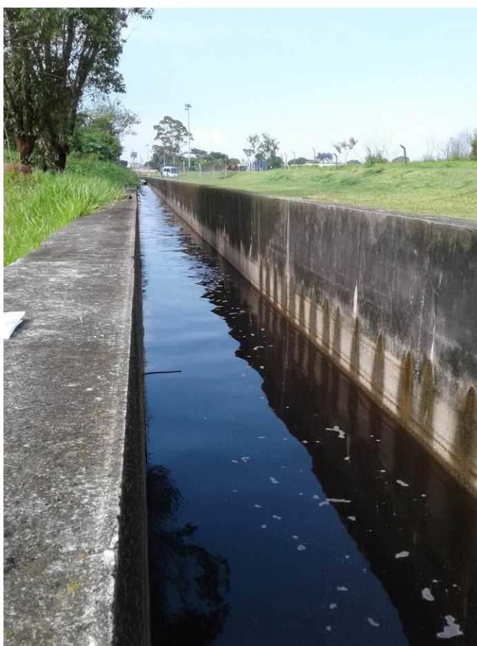
Figura 11: Canal artificial de lançamento da Sabesp no Rio Tietê, visada sentido Av. Major Pinheiro Fróes.
