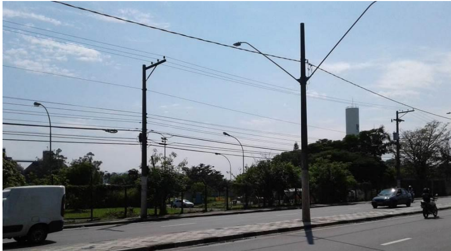
Figura 71: Faixada da SABESP na margem esquerda da Av. Major Pinheiro Fróes sentido SE. (limite da AII).
