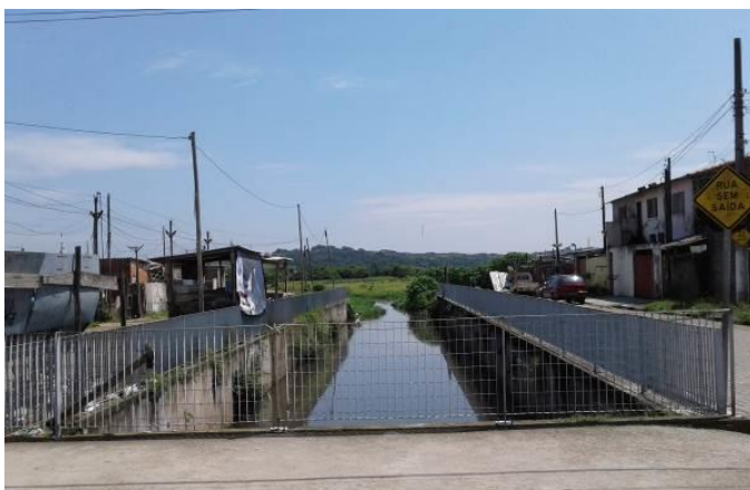
Figura 44: Final do canal artificial concretado na Av. Albert Finke e do bairro Parque Maria Helena e início da ocupação irregular a esquerda do canal.
