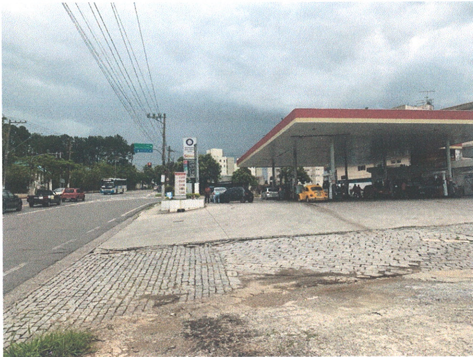
IMAGEM 7 – OPERAÇÃO ATUAL (AUTO POSTO VILA FIGUEIRA 01/2019)
