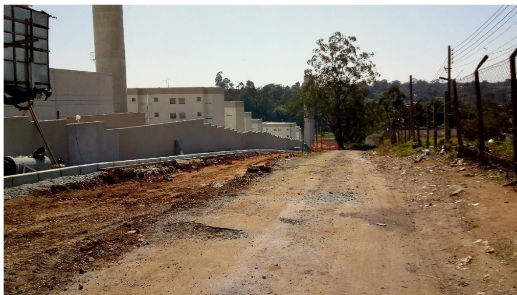
Imagem 10: Obras de infraestrutura
