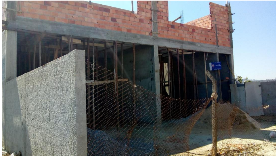
Imagem 11: Construção de empreendimento comercial
