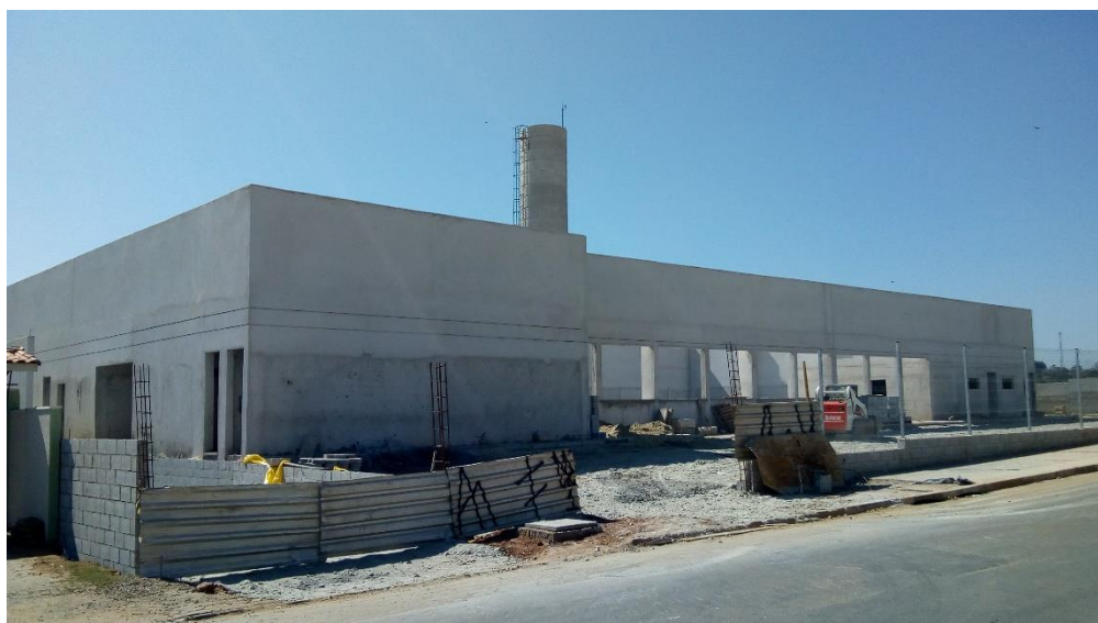
Imagem 09: Construção de empreendimento comercial
