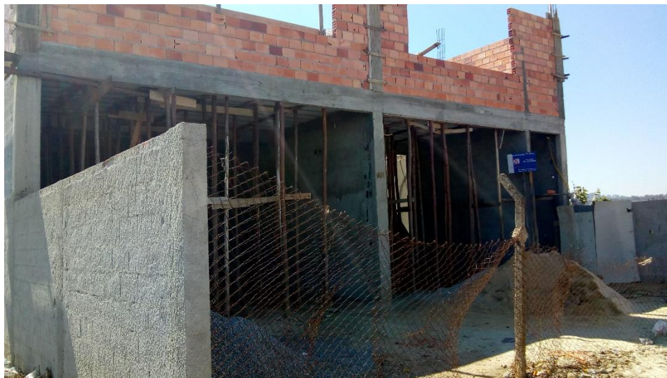
Imagem 11: Construção de empreendimento comercial
