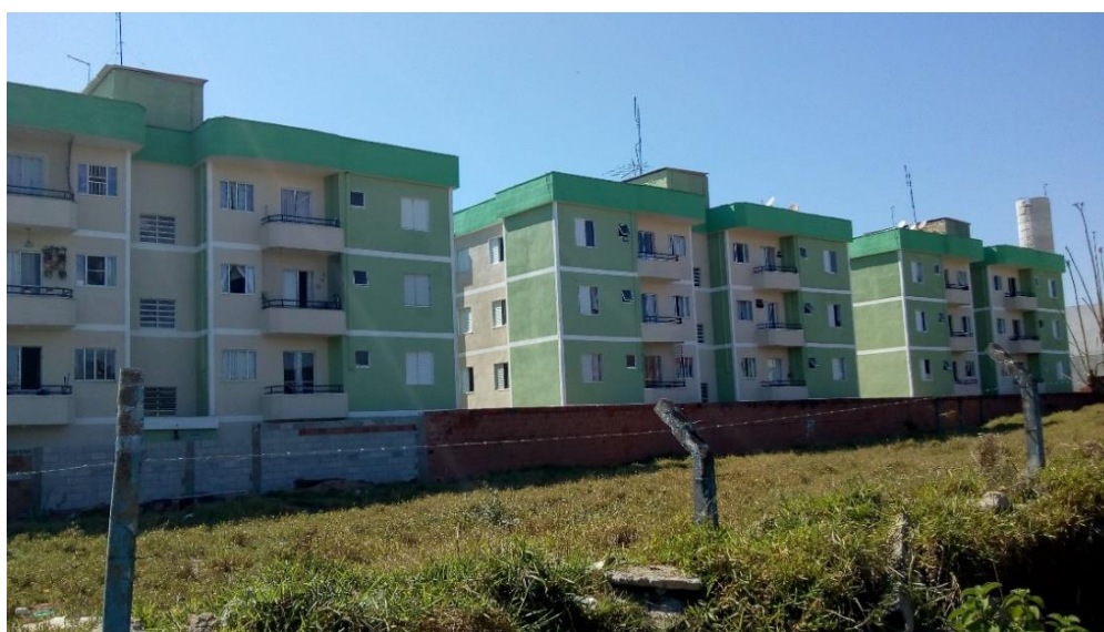
Imagem 07: Foto Frontal do Condomínio Caravelas
