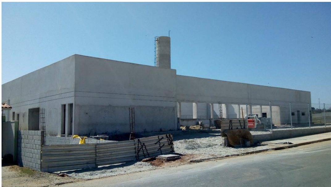
Imagem 09: Construção de empreendimento comercial
