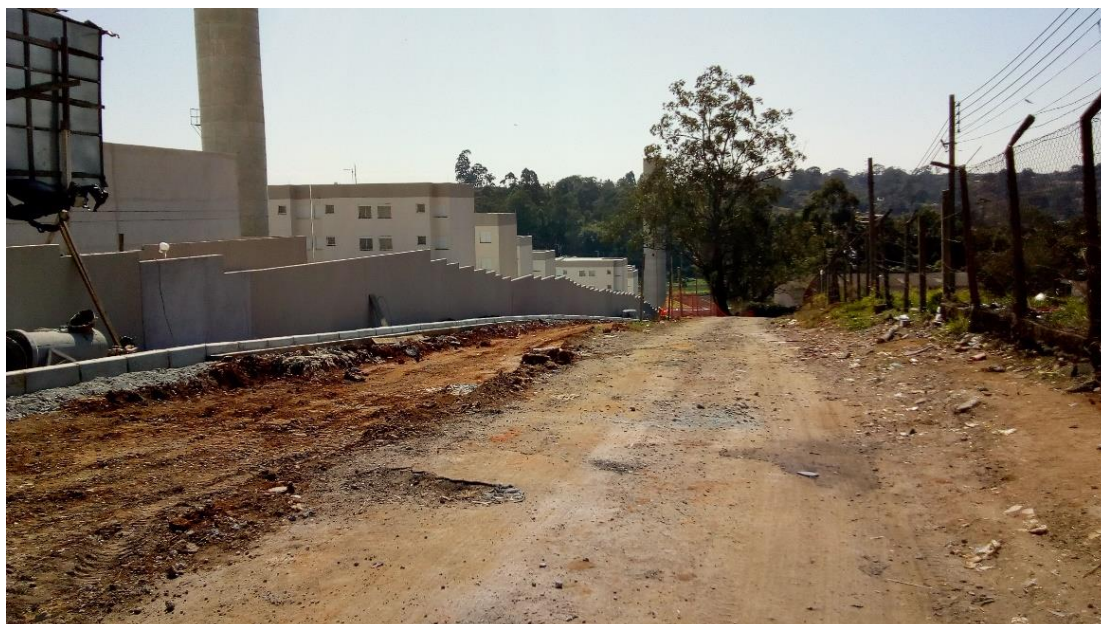
Imagem 10: Obras de infraestrutura
